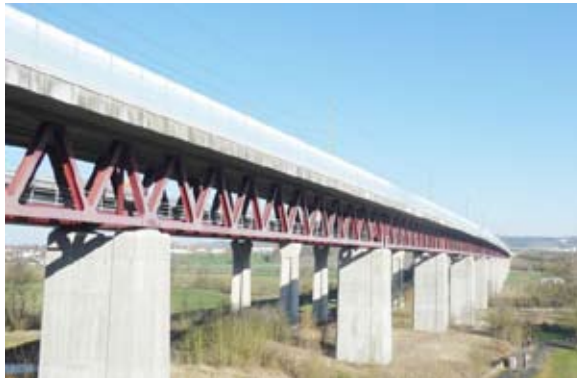
Itztalbrücke mit RE nach Sonneberg
