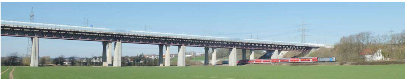
Itztalbrücke in voller Länge
