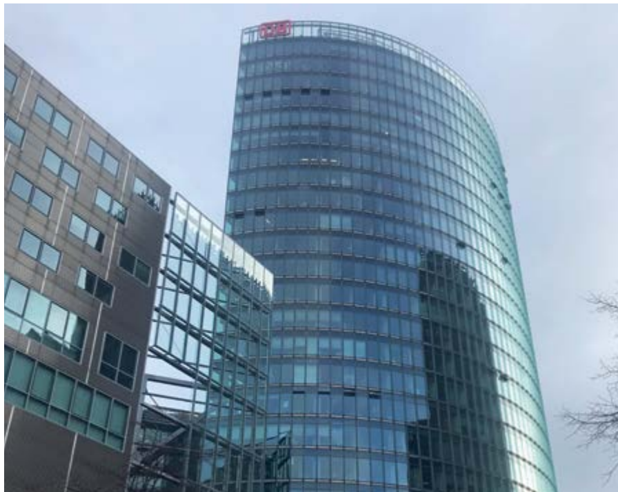
Der Besuch im Bahntower hinterlässt bei den Gästen einen bleibenden Eindruck (Foto: Hellmeister)
