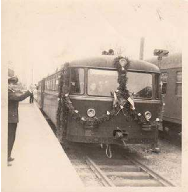
Abfahrt des ersten Triebwagens vom Bahnhof Burg über die Hochbrücke
